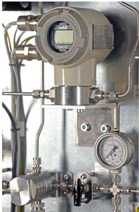
Dieses System ist außerdem besonders sicher, da das Gas jederzeit über zwei unterschiedliche Messprinzipien parallel gemessen wird. Jeder Gerätefehler wird sofort offensichtlich, und wenn eins der beiden Systeme ausfällt, produziert das andere weiter nutzbare Messergebnisse. Das gilt natürlich auch im Falle der Kalibrierung des Prozessgaschromatographen.
