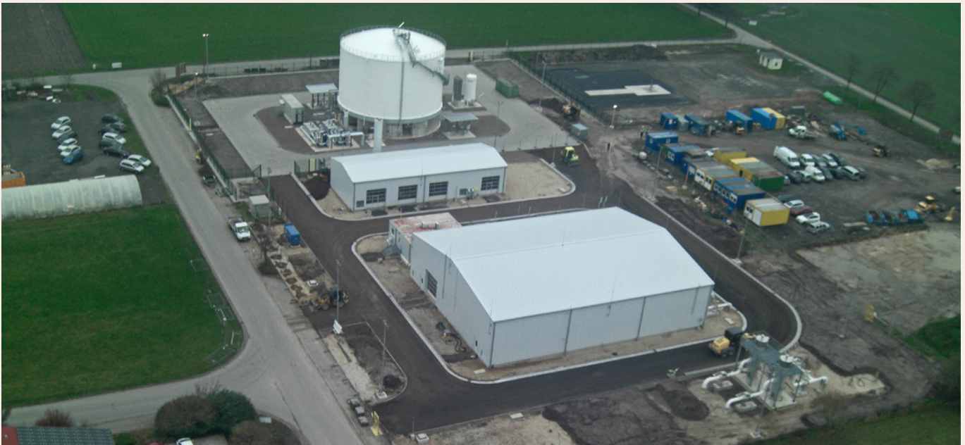
Bild 1: Übersicht der Konvertierungsanlage in Rehden [5]
